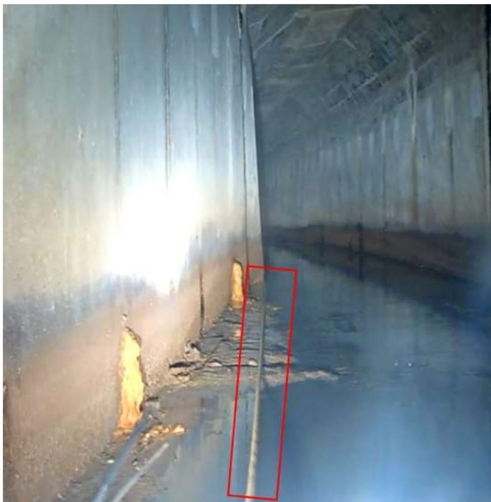
Figura 1.2: Imagem da câmera do EspeleoRobô durante uma operação de inspeção de uma galeria de barragem. Apesar de possuir 300 metros de cabo, nessa ocasião, o robô não conseguiu andar mais de 160 metros devido a força de arrasto e o atrito do cabo com a parede, destacado pelo retângulo vermelho na imagem. Fonte: O autor
