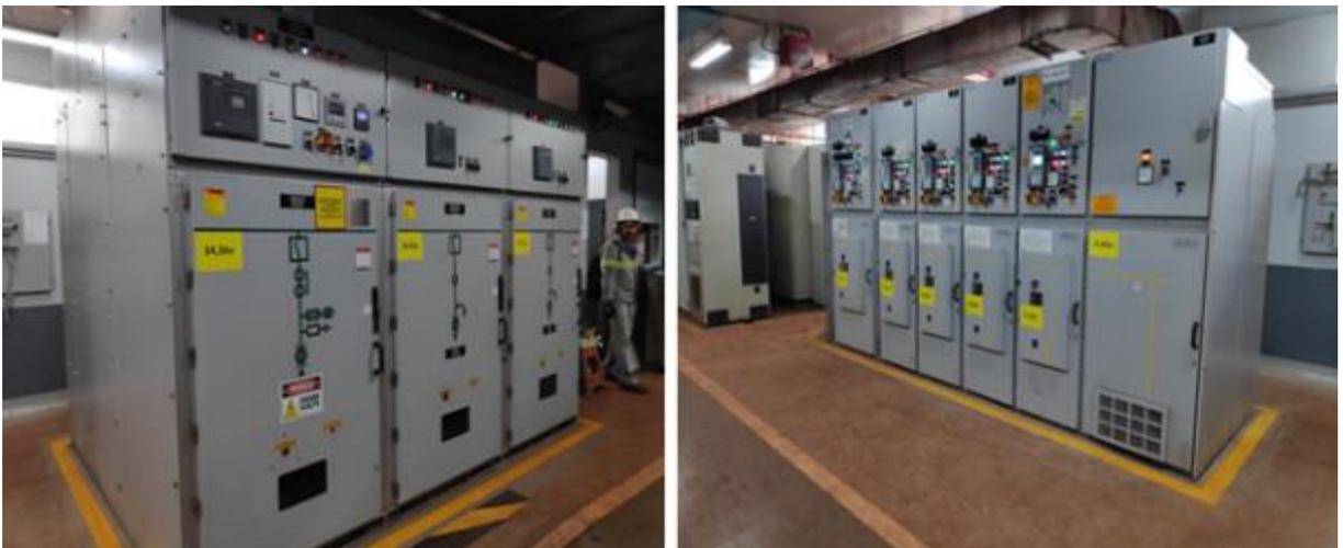
Figura 3-7: Exemplo de equipamentos dentro de uma subestação elétrica do TPPM. Em destaque, conjuntos de manobra de 34,5 kV e 4,16 kV, respectivamente.
