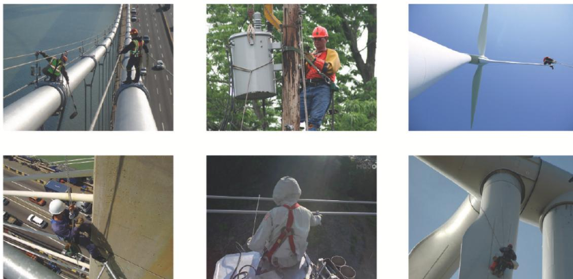
Figura 1.2: Aplicações da Manipulação Aérea. Coluna da esquerda: inspeção da ponte; coluna central: inspeção e conserto de linhas elétricas de alta tensão; coluna direita: reparação das pás do rotor de uma turbina eólica. Fonte: (RUGGIERO *et al.*, 2018).
