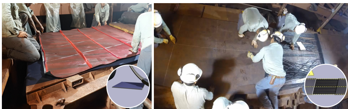
(a) Início da montagem da emenda.
