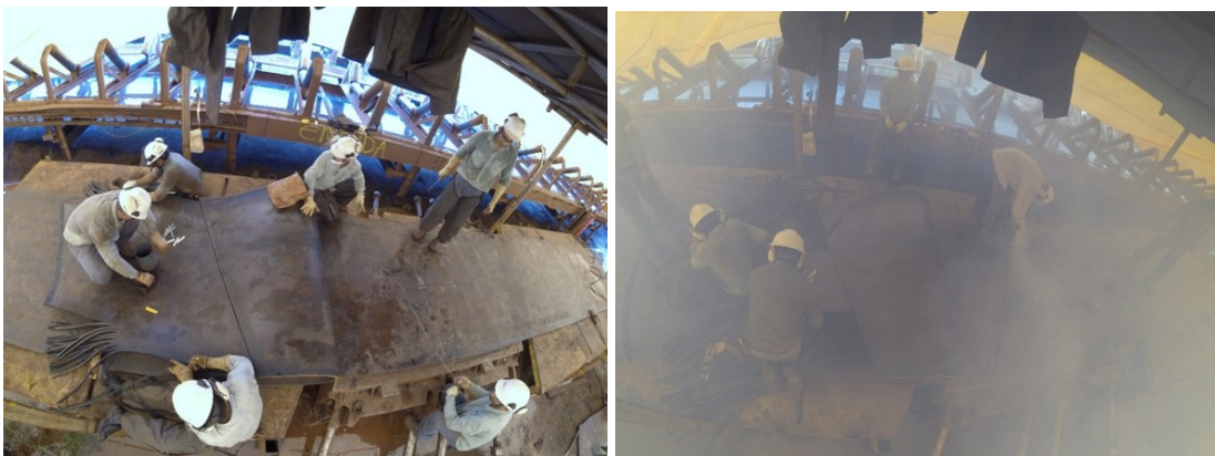
Figura 1.6: Algumas tarefas da preparação da emenda sendo realizadas.
