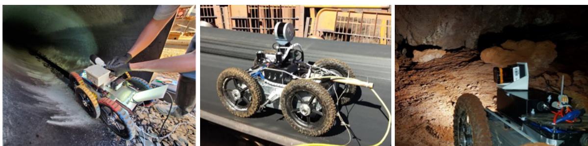
(a) Inspeção de Tubulação de Rejeitos.
