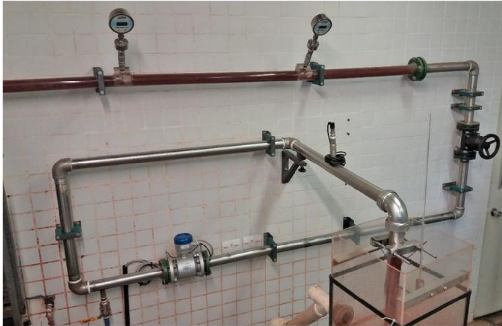
Figura 4 – Unidade experimental de transporte hidráulico instalada no LFQI
