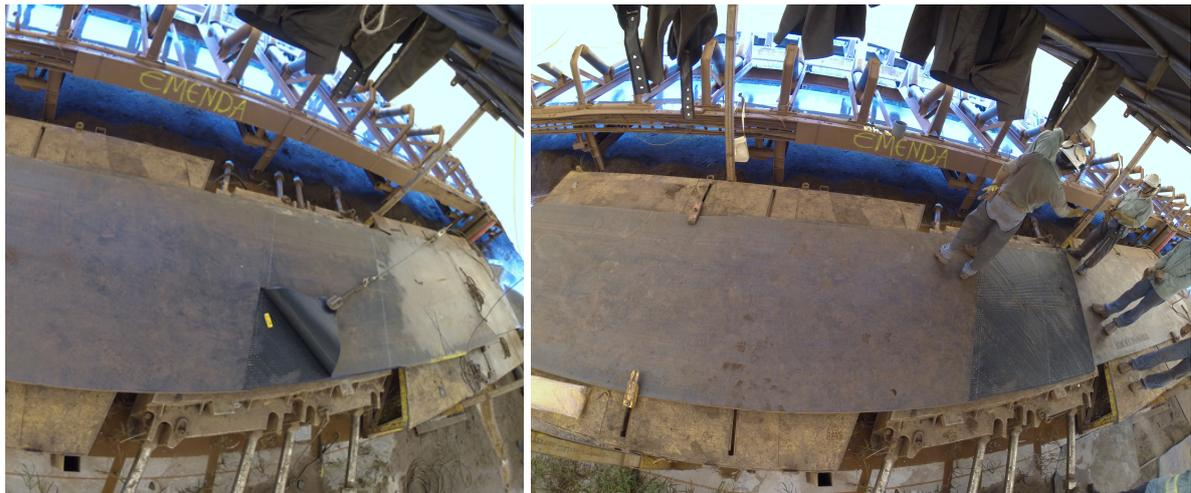
Figura 4.16: Remoção da camada superior da correia.
