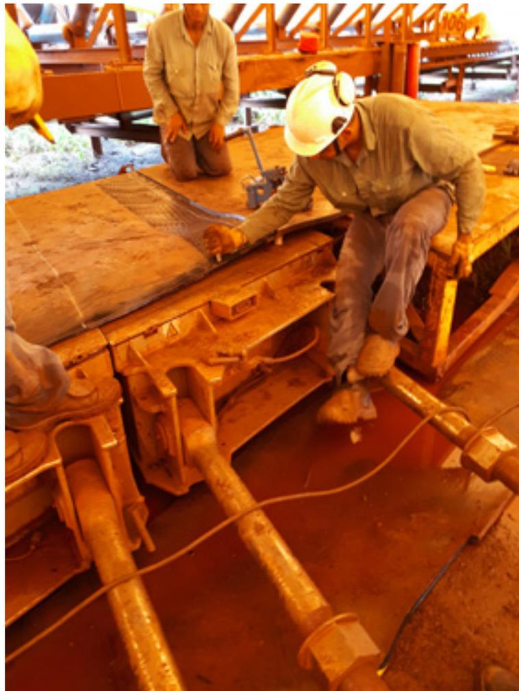
Figura 1.2: Trabalhadores executando cortes com lâmina na correia.
