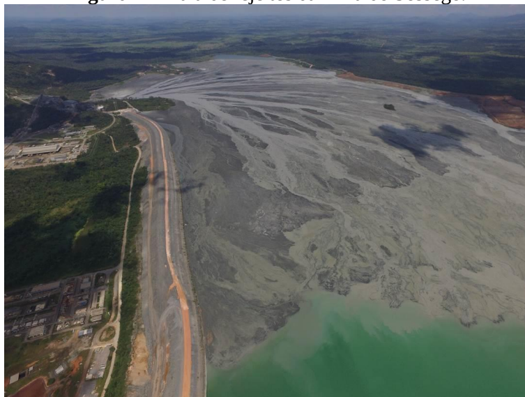
Figura 2 - Praia de rejeitos da mina do Sossego.
