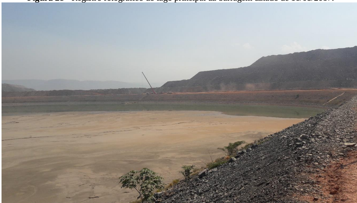
Figura 21 - Registro fotográfico do lago principal da barragem datado de 11/08/2017.
