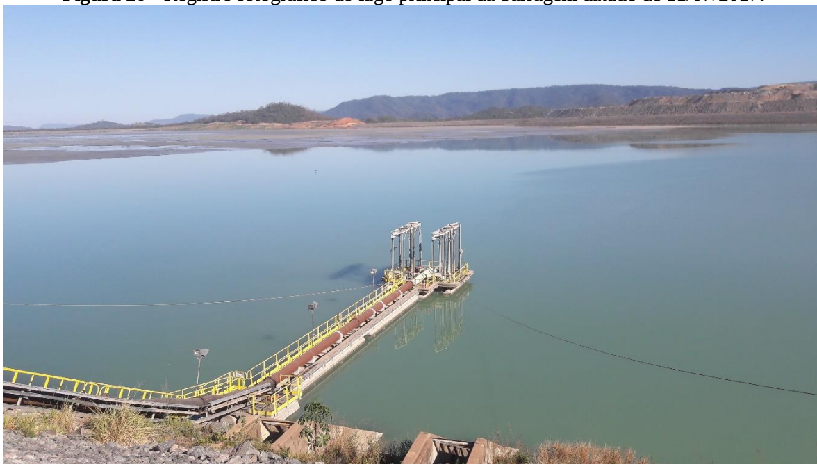
Figura 20 - Registro fotográfico do lago principal da barragem datado de 11/07/2017.
