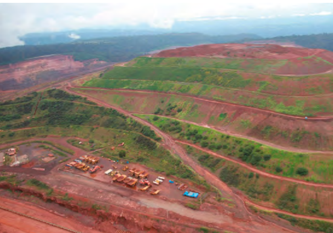
Figura 5. Pilha de Estéril Oeste em fase de expansão (parte superior) e revegetação simultânea. A base da pilha apresenta recuperação mais avançada do que os taludes intermediários (taludes laterais).
