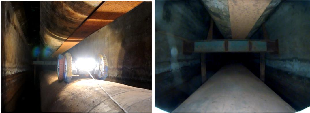
Figura 6.5: Inspeção na galeria de barragem localizada no Rio do Peixe. EspeleoRobô no modo 6R se deslocando sobre um duto (à esquerda) e visualização das vigas que foram utilizadas como referência visual (à direita).
