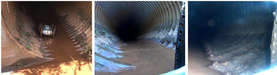
Figura 6.7: Inspeção na galeria de barragem na Minas de Gongo Soco. As duas primeiras imagens mostram o momento em que o robô entram no duto. A terceira imagem mostra em detalhes as rugosidades da estrutura.
