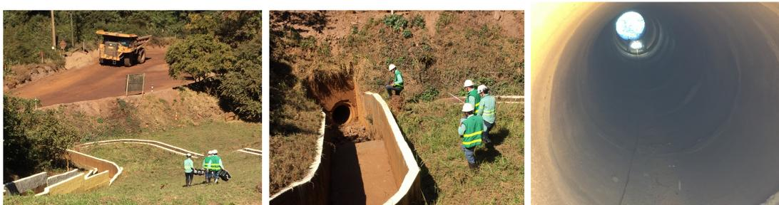
Figura 6.3: Área do duto inspecionado na Mina Córrego do Feijão. A última foto mostra o EspeleoRobô durante a inspeção.
