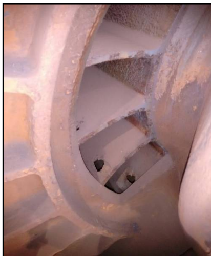
Figura 25 - Rotor danificado de bomba retirada de operação em Mina Fábrica
