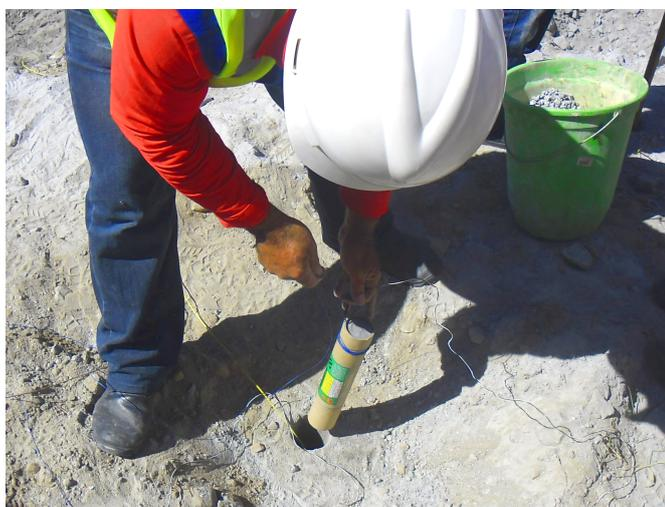
Figura 17 – Operador inserindo dispositivos de detonação no furo de forma manual.
