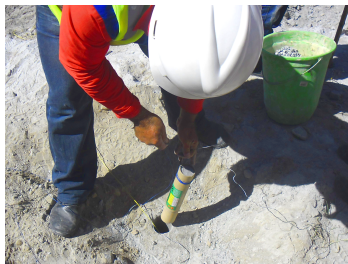
Figura 1: Operador inserindo dispositivos de detonação no furo de forma manual. (Desmontec, 2012)
