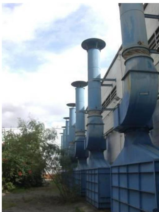
**Figura 11:** Lavadores de gases da cabine de pintura da Oficina de Locomotivas
