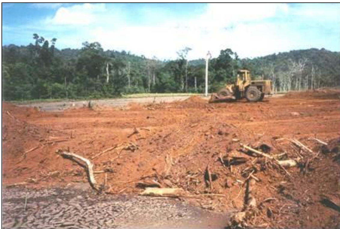
Figura 9. Espalhamento do solo orgânico, proveniente das frentes de supressão, sobre o rejeito de manganês.
