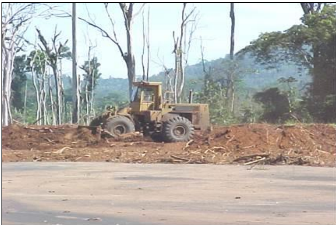
Figura 8. Montagem do tratamento de ilhas de top soil, no ano de 2000.
