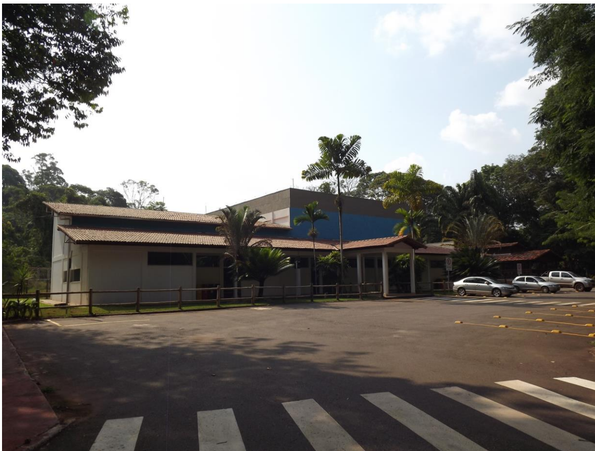
Figura 3 - Prédio do Parque Zoobotânico Vale, em Parauapebas, Pará.
