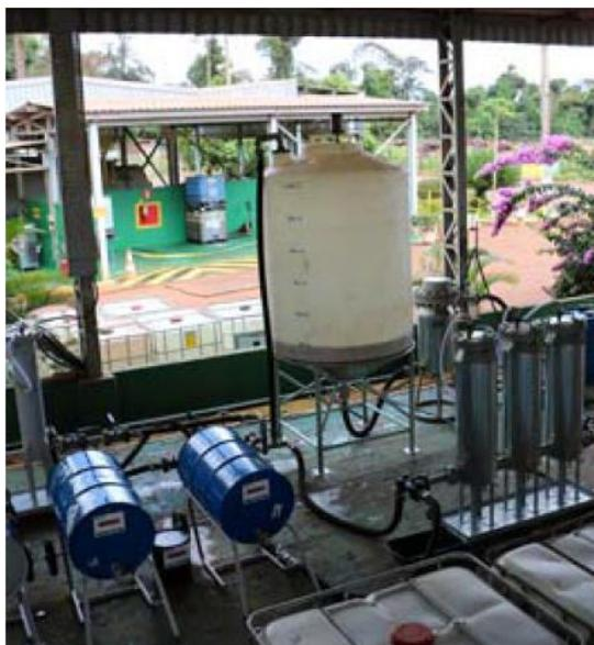
Os equipamentos utilizados na planta são centrifugas purificadoras e clarificadoras, desidratadores a vácuo, agitadores, filtros nominais e absolutos.
