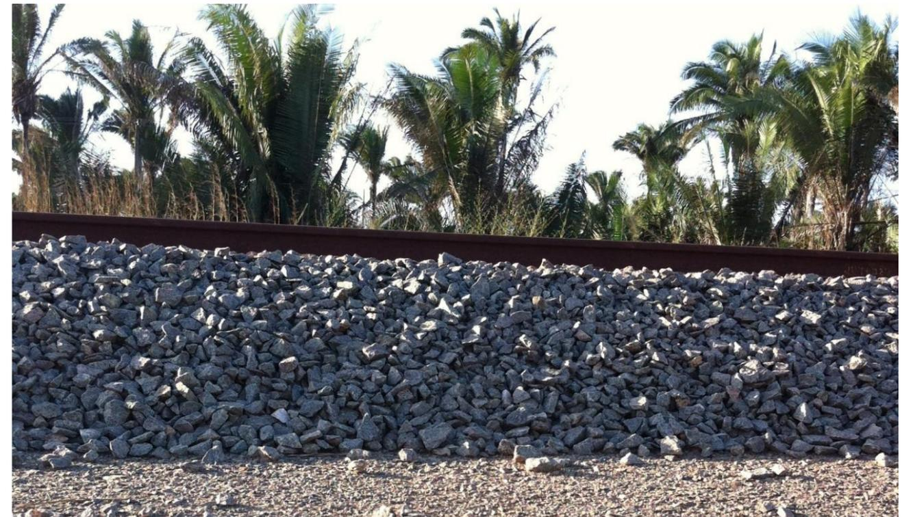
Figura 16 – Perfil da camada de brita que sustenta a estrutura de dormentes e trilhos.
