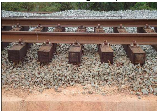
(a) Superestrutura: lastro, dormentes, trilhos e acessórios.
