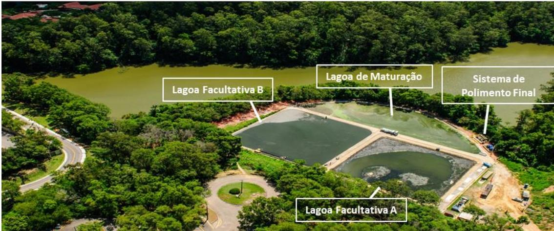
**Figura 2 - Distribuição do Sistema de Tratamento de Efluentes Sanitários do Complexo de Tubarão.**
