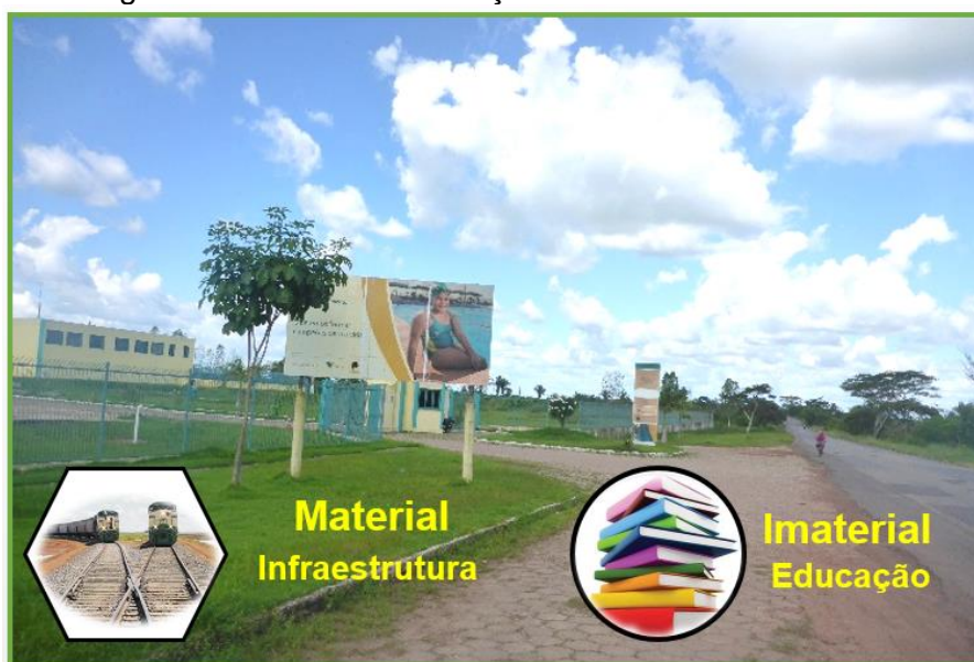
Figura 40 - Entrada da Estação Conhecimento em Arari.
