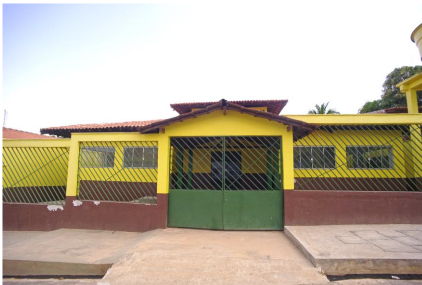
Figura 16 - Portão de entrada da creche Amor e Carinho sem identificação de legado.
