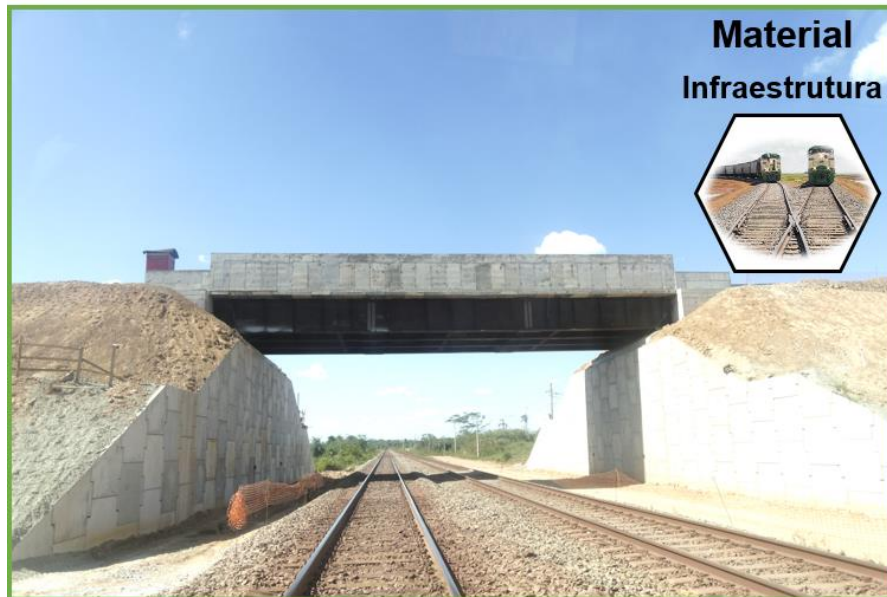
Figura 39 - Viaduto sobre a EFC em Mirando do Norte.
