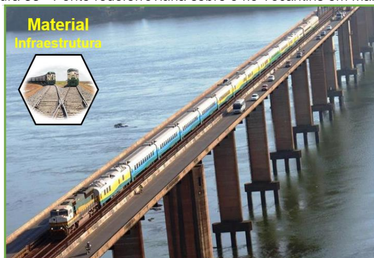
Figura 33 - Ponte rodoferroviária sobre o rio Tocantins em Marabá.
