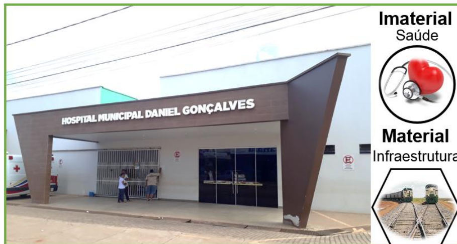
Figura 29 - Entrada do Hospital Municipal Daniel Gonçalves.
