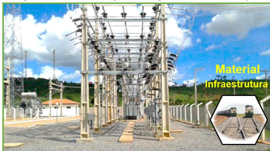
Figura 32 - Nova Subestação de energia em Canaã dos Carajás.
