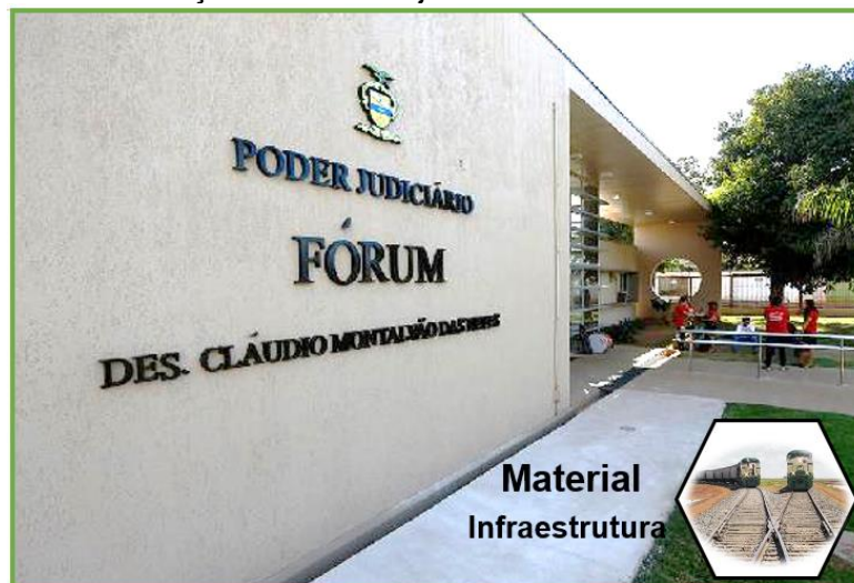
Figura 28 - Novas instalações do Fórum judicial da Comarca de Canaã dos Carajás.
