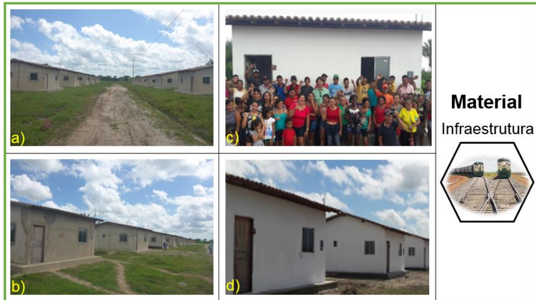
Figura 38 - Casas do projeto habitacional Cariongo III.
