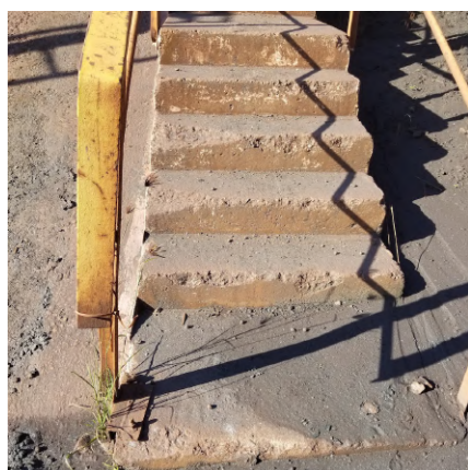
(a) Escada de concreto.
