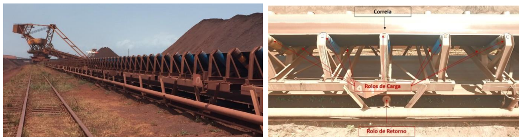
Figura 1 – Pátio com a vista lateral de um TC (à esquerda) e detalhamento dos itens inspecionáveis (à direita).
