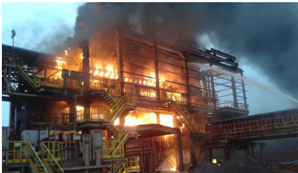
Figura 1.2: Incêndio em torre de transferência entre transportadores de correias no porto da Vale de São Luís, Maranhão. Fonte: (IMIGRANTE, 2015).
