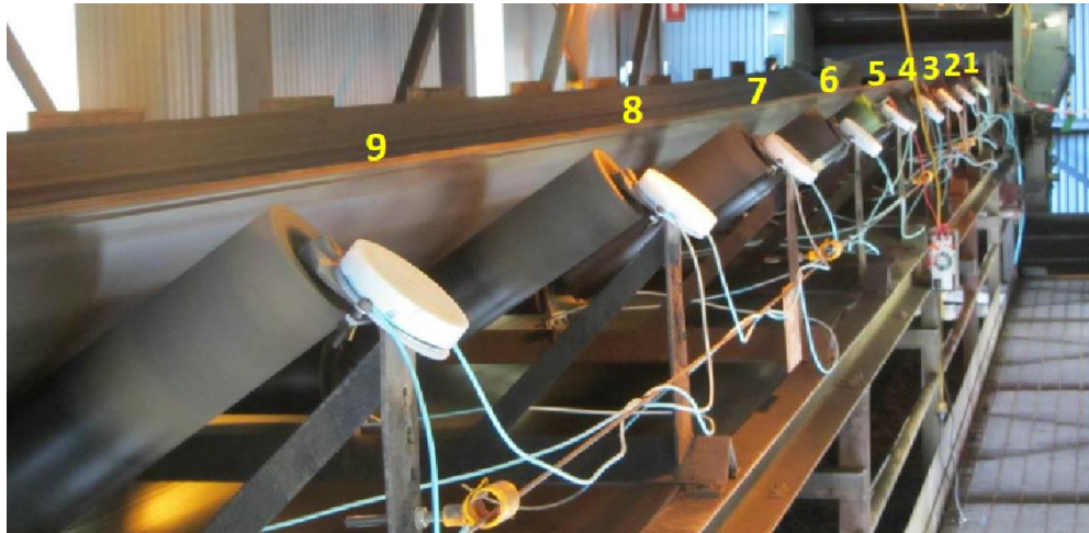
Figura 3 – Inspeção de correias utilizando fibra óptica.
