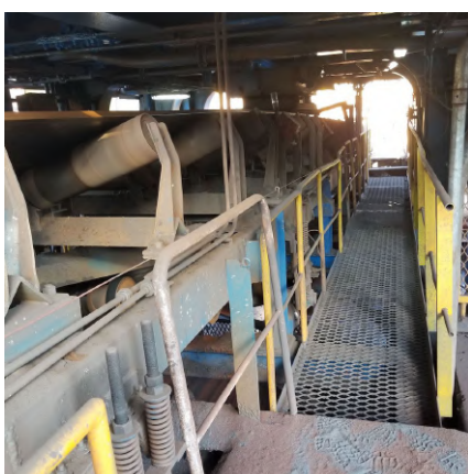
(d) Deck de grades de metal.
