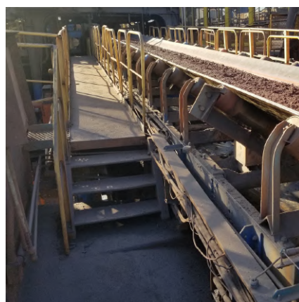
(b) Escada de grade de metal.
