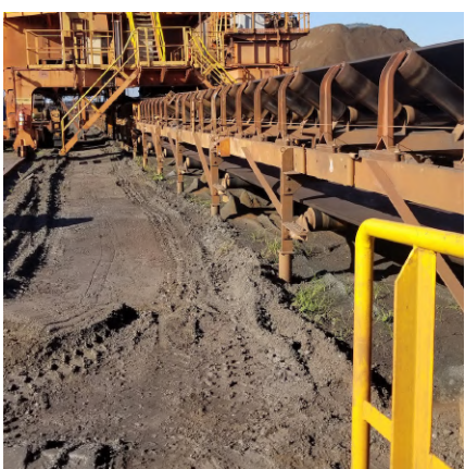
(c) Local sem pavimentação.
