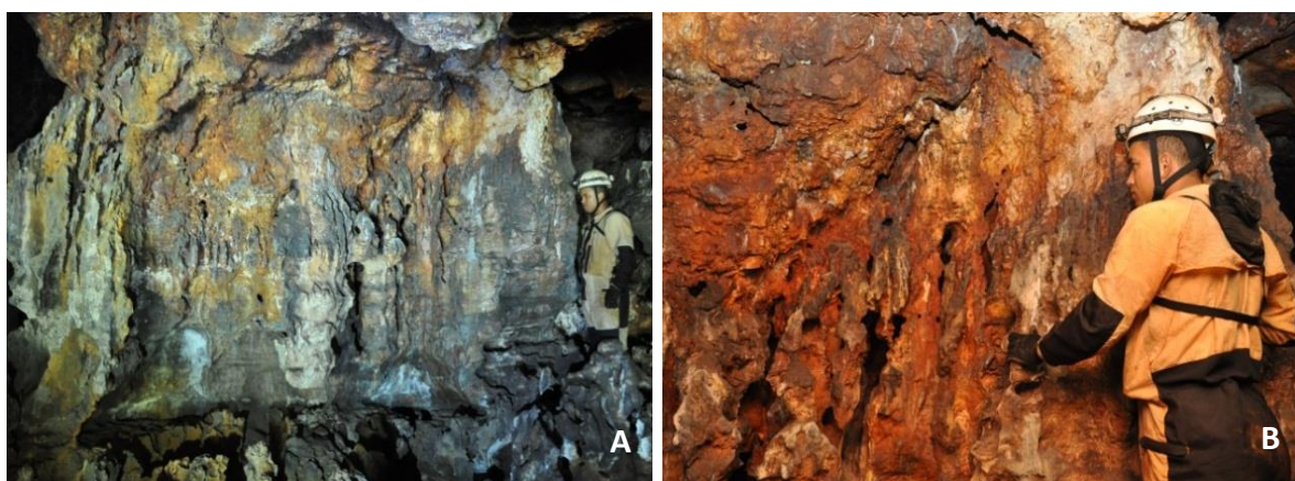
Figura 25: Caneluras nas paredes indicando processos de corrosão na parede SSE.
